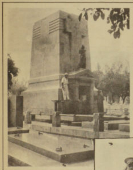
Un aspecto del hermoso panteón de los Veteranos que en breve será inaugurado, al terminarse su construcción. (Foto Kiko.)
