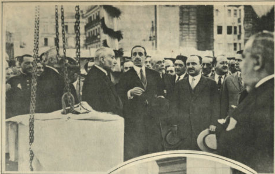
S. M. el Rey de España en el acto de la colocación de la primera piedra del nuevo edificio que está construyendo la Asociación de la Prensa Madrileña.
