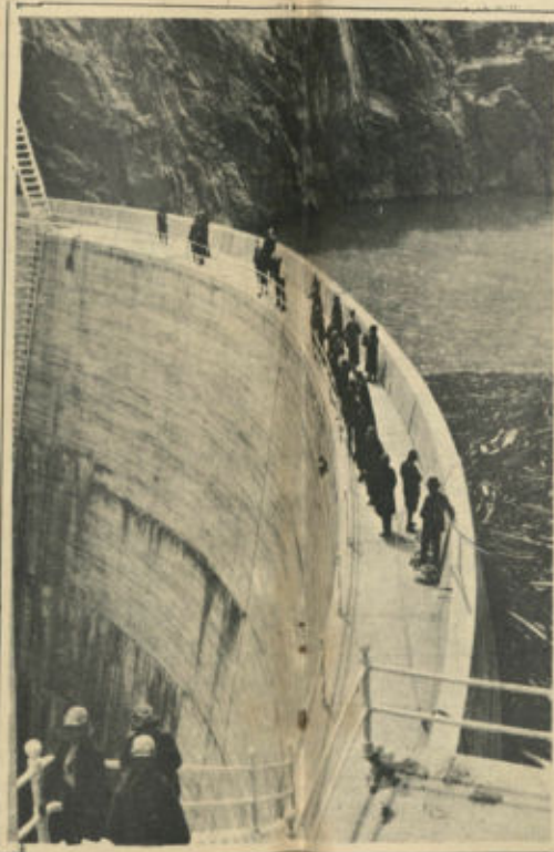
Desde la inauguración del dique en Yellowstone en el río que atraviesa el parque de Yellowstone, no son solamente las bellezas naturales las que pueden admirar los turistas en su privilegiada región, sino obras de ingeniería como ésta, que cuenta entre las más interesantes realizadas durante estos últimos años en los Estados Unidos.
