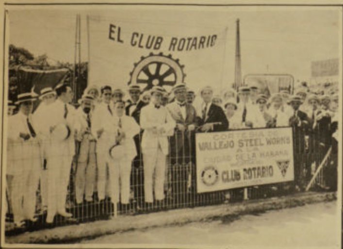
Un aspecto de la inauguración de las cercas que por iniciativa del Club Rotario fueron regaladas a la ciudad de la Habana por la compañía Vallejo Steel Works, e instalada al borde de las grandes excavaciones que existen a ambos lados del final de la calle 23. En esta foto aparece el Dr. CARLOS MIGUEL DE CESPEDES, Secretario de Obras Públicas, acompañado por algunos miembros del Club Rotario.
