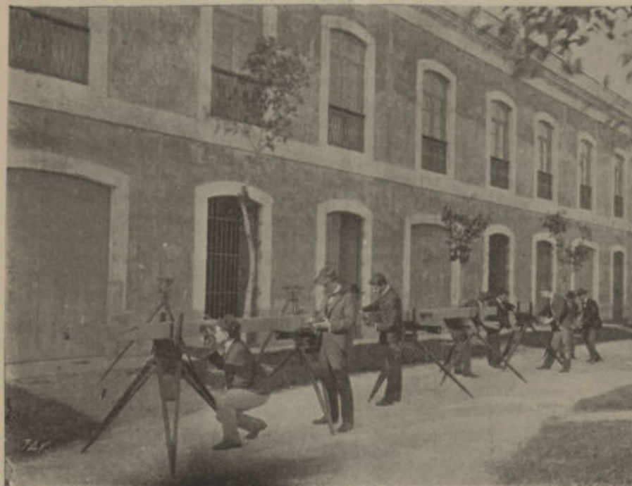
APARATO PARA LA MEDIDA DE BASES GEODESICAS
