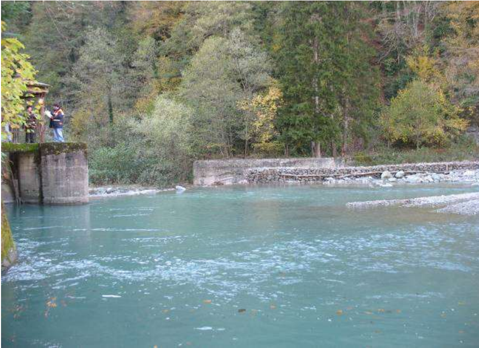
Figure2.1. Ritseula HPP dam
