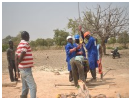
Une équipe de foreurs manuels à l'œuvre, dans le village de Vipalگو.
