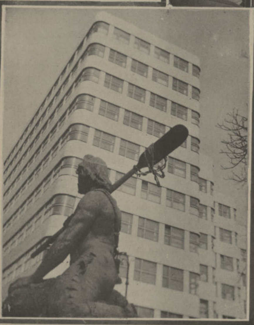
El nuevo edificio de la Shell, en Berlín.
