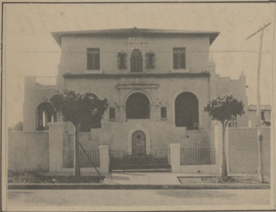
Una Residencia del Rebarto
