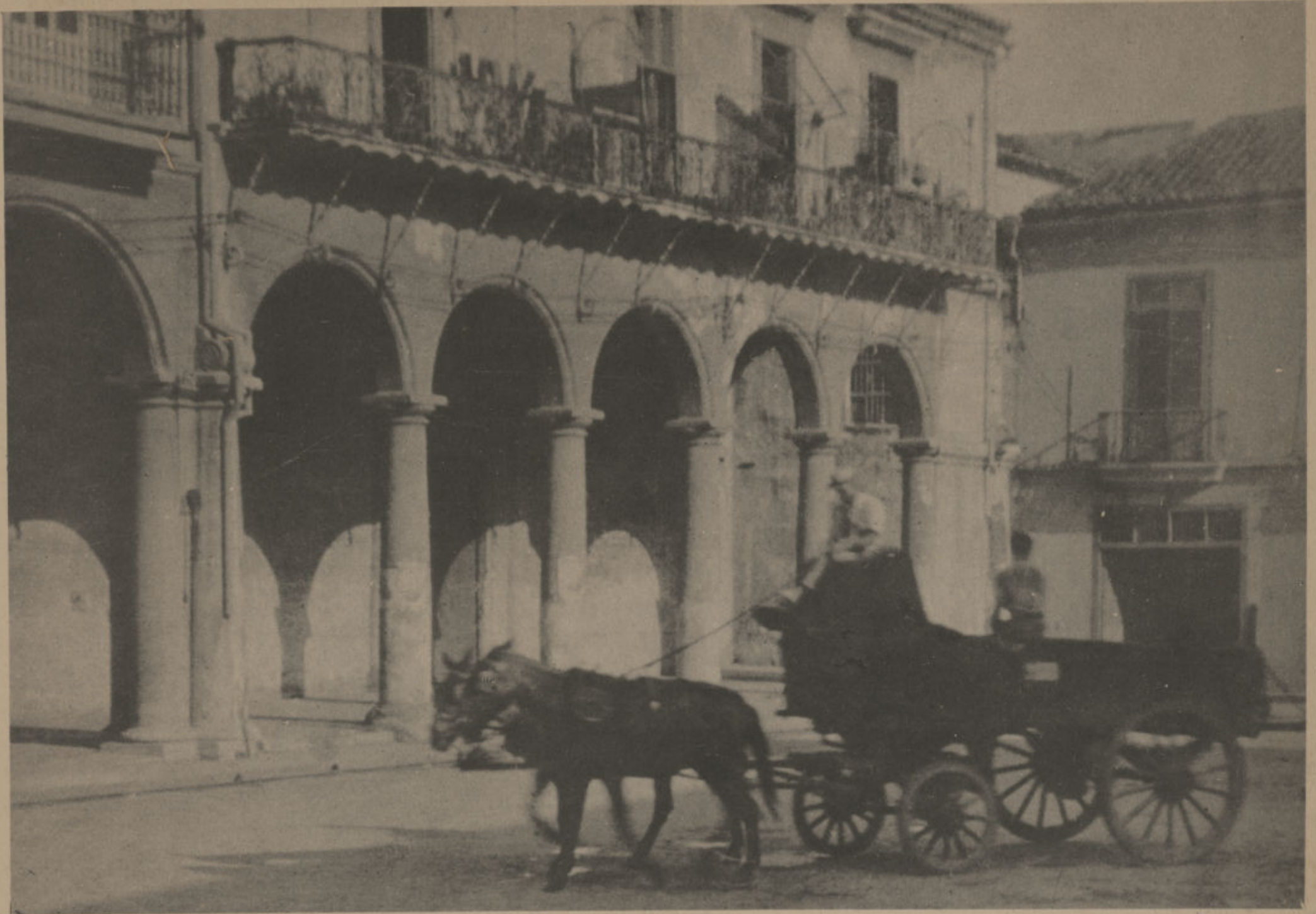
"Las bellas casas de la Plaza de la Catedral, con sus espléndidos balcones y columnatas, deben ser protegidas y conservadas", dice Arnold Genthe.
