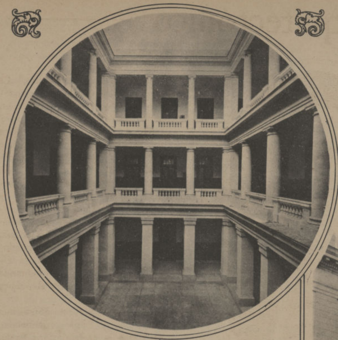
Patio interior del edificio del Instituto.
