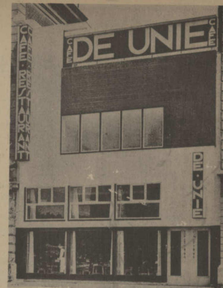
Fachada de un café en Rotterdam. J. P. Oud, arquitecto.
