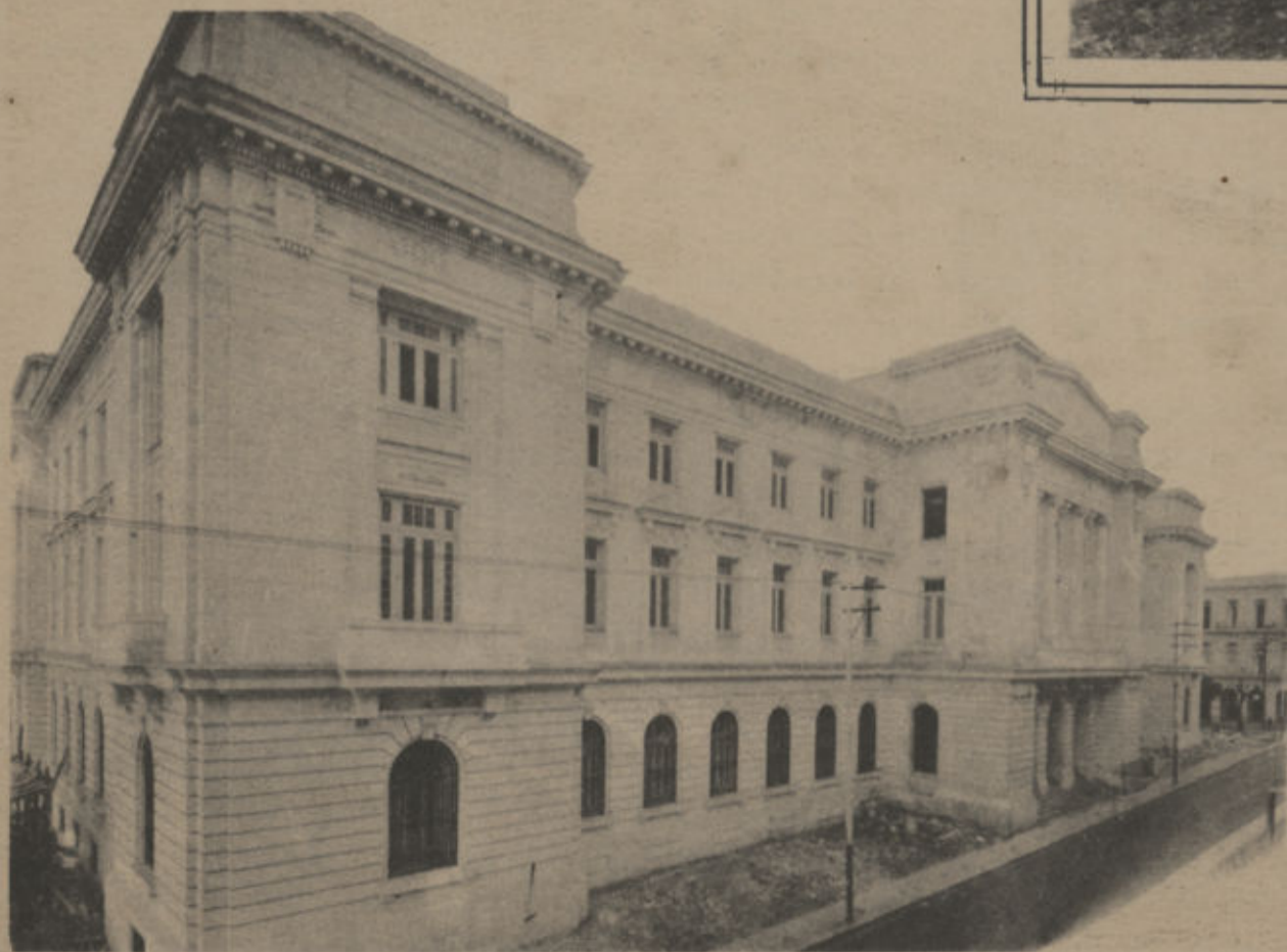
Otro aspecto del edificio del nuevo Instituto de la Habana.
