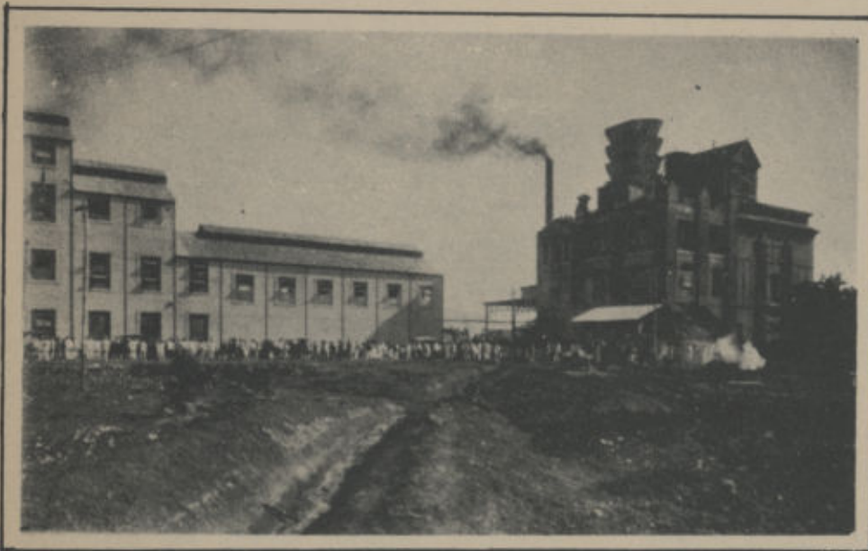
La destilería y la planta de cerveza y de hielo.
