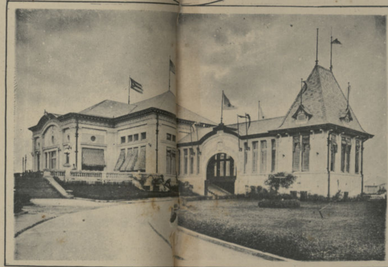
Vista general edificio del Casino.
