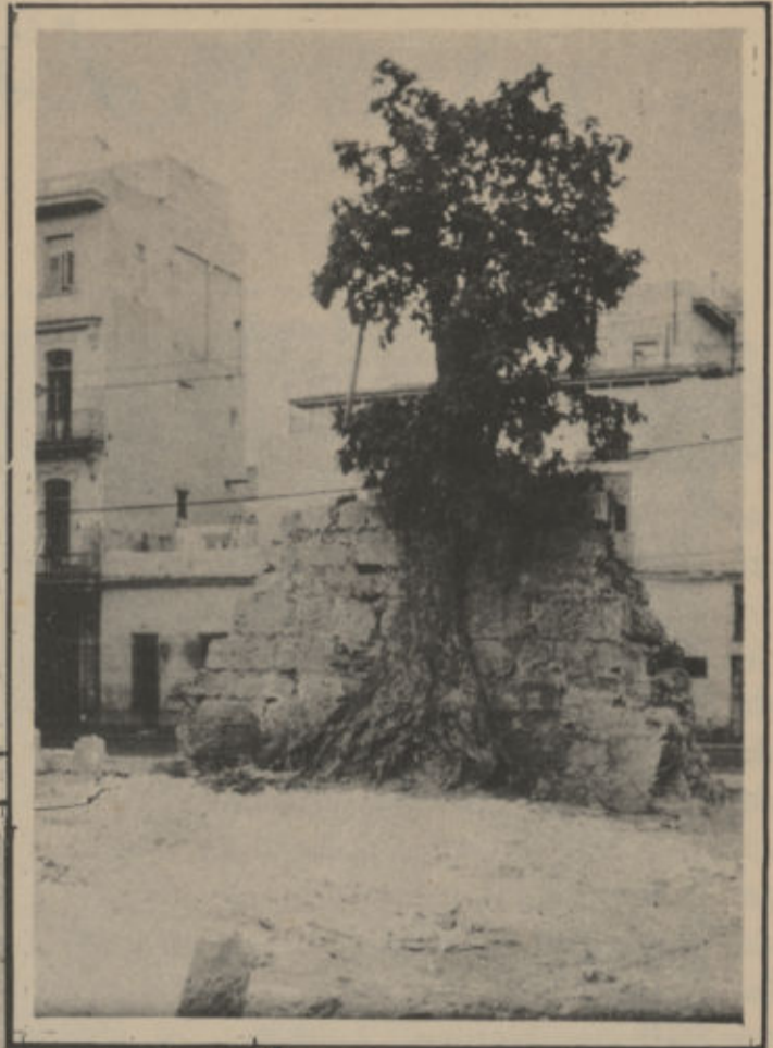
En los jardines del nuevo Instituto Provincial se ve ese pedazo de Muralla en el que ha nacido un árbol, que el ciclón último respetó.
