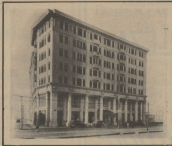
Edificio Carreño Arquitecto: Arturo Lobo
