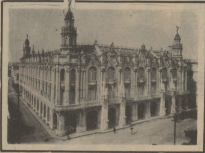
Palacio del Centro Gallego Contratistas: Purdy & Henderson Co.
