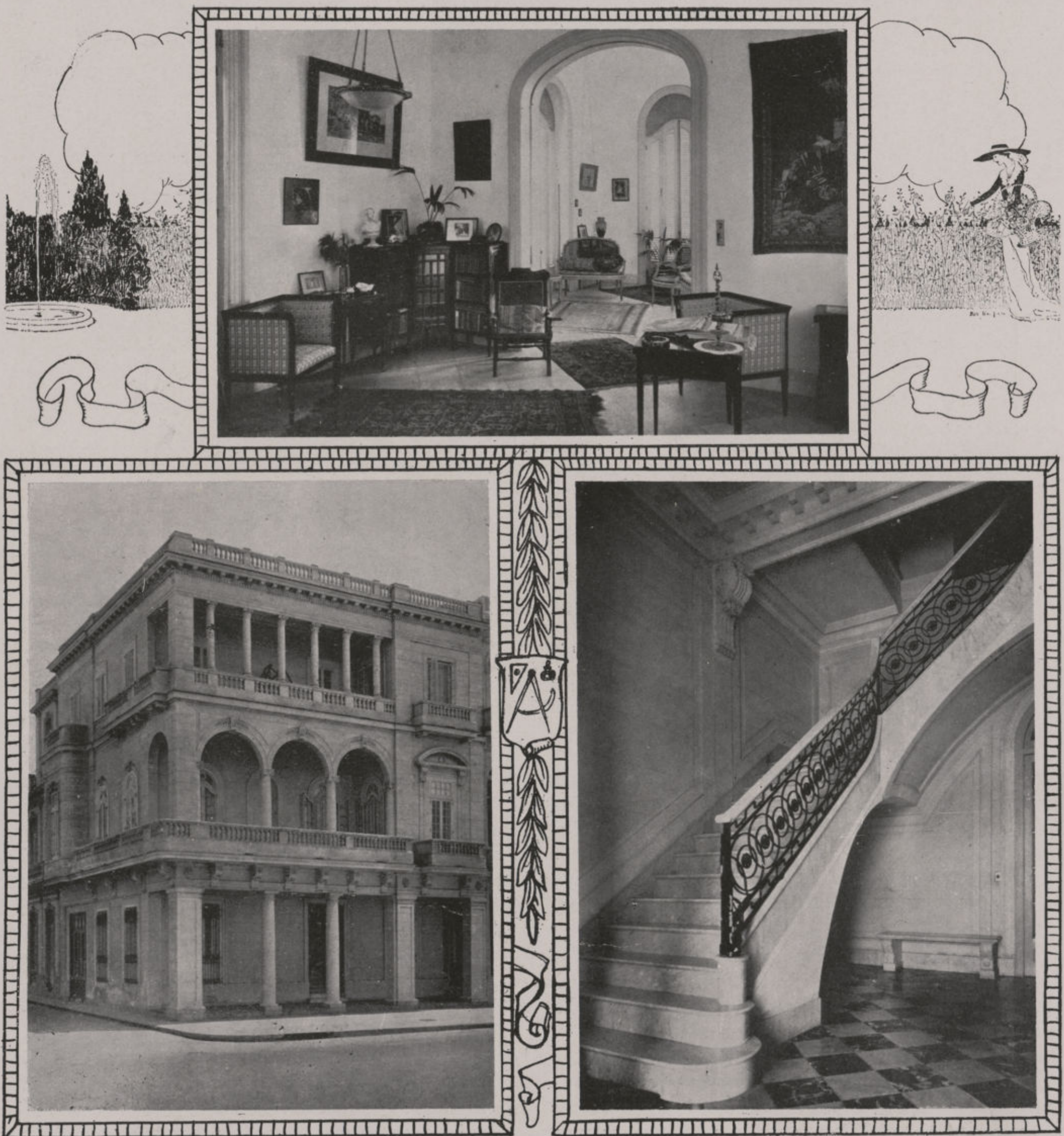
La Casa del Dr. Cosme de la Torriente, ex-Secretario de Estado. Detalle de la escalera principal y una de las salas. (Avenida de Maceo y Perseverancia)
