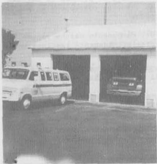
CENTRO DE PROTECCION CONTRA INCENDIOS DE FORT CHAFFEE.
